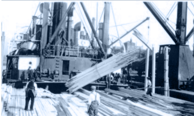
For Bergens trampflåte var kull og trelast de viktigste varene. Lossing av trelast fra DS "Ørland" av Bergen en gang i mellomkrigstiden. Foto: BSJ.
