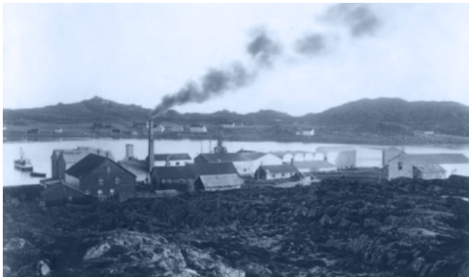
Brettefjell i Vågan kommune med landets første sildolje/sildemjøl-fabrikk, etablert i 1884. Foto: Lofotmuseet
