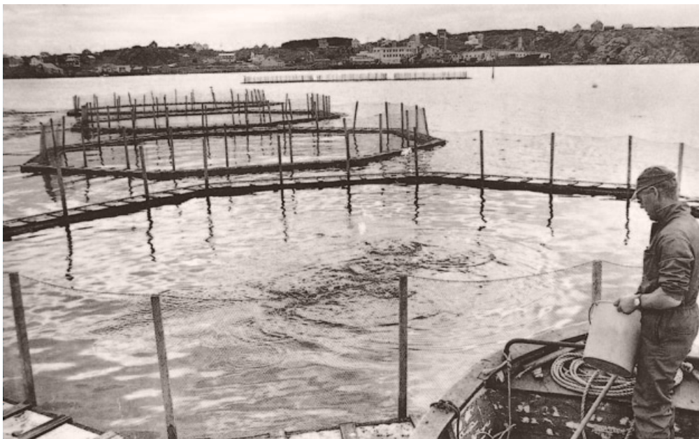
Alfred Kristiansen ved oppdrettsmerdene i Klauvasundet ca. 1972-73. Det var åttekantete merder (Grøntvedt-merder) av impregneret treverk med isoparklosser som flottører. De åtte sidene var festet sammen med gumi fra bildekk. På innersiden av rammen var et gjerde av not. Foto: Adresseavisen
