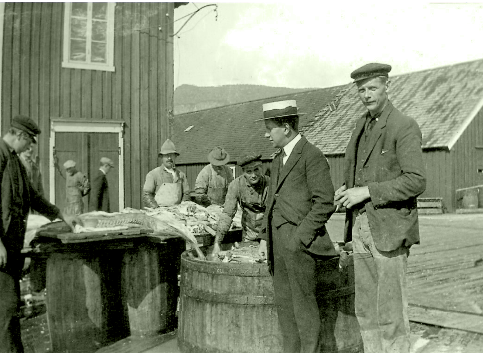
Produksjon av torsk med enkle hjelpemidler tidlig på 1920-tallet. Bildet er tatt på kaia på Melbu i Vesterålen. Stedet Melbu var likevel tidlig ute med forsøk på kjøling og frysing, og kom seinere til å få landets første filetanlegg for produksjon av frossenfisk med kontinuerlig drift helt fram til vår tid. Foto: Ukjent. Museum Nord – Vesterålmuseet.
